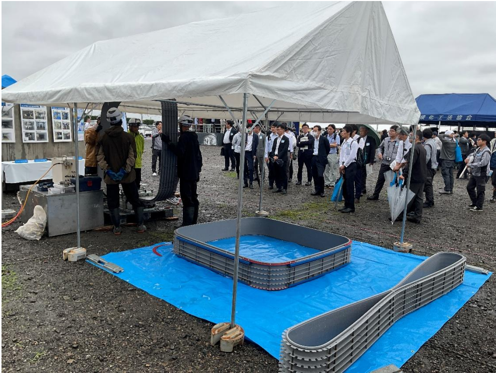
写真-5 デモ施工状況②
