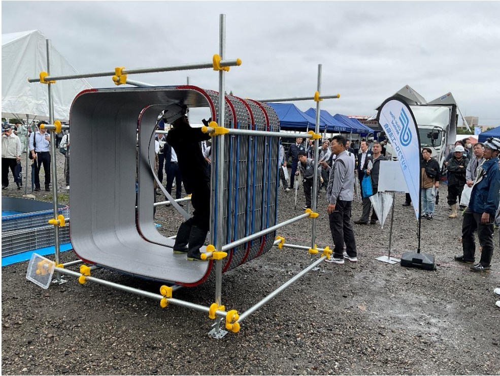
写真-7 デモ施工状況④
